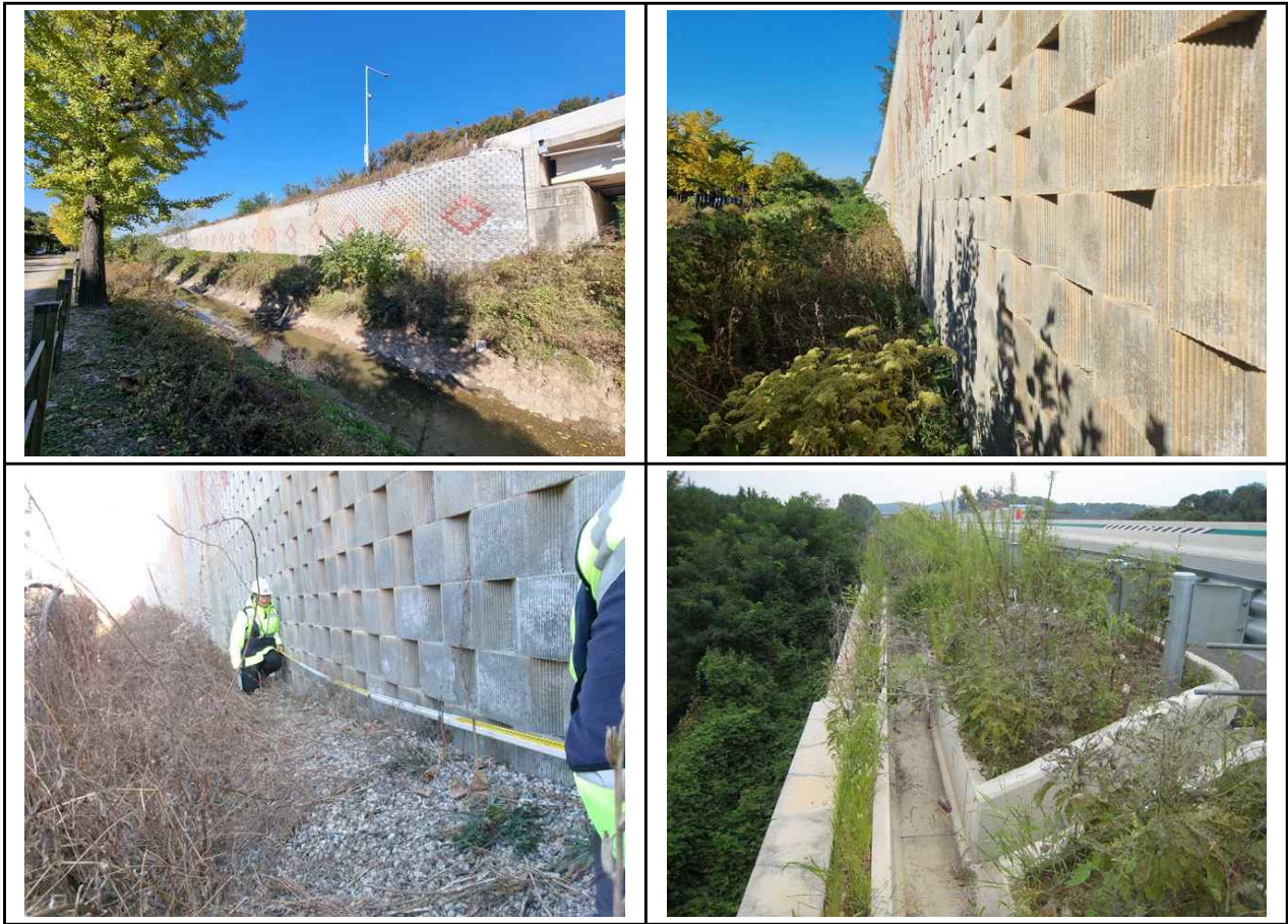
【그림 4.10】 외관조사 전경
